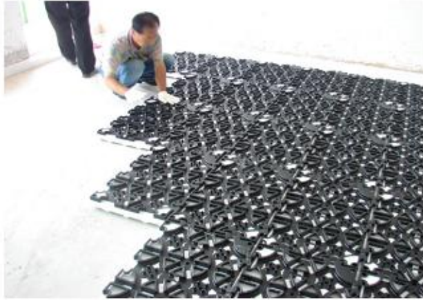
(d) NLS 온돌 지지틀 시공
