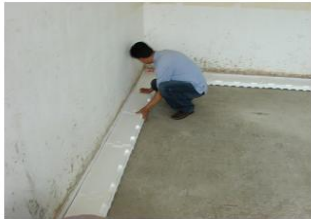
(c) NLS 흡음차음 마감재 시공
