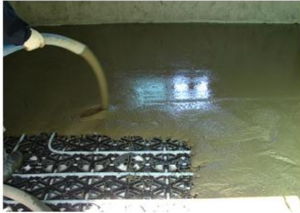
(g) 마감모르터 시공
