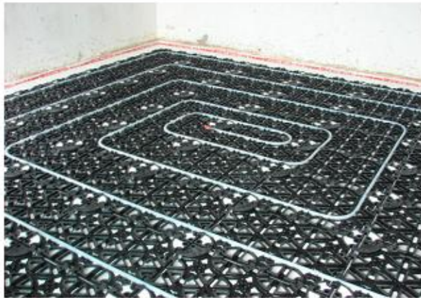
(f) 난방배관 설치
