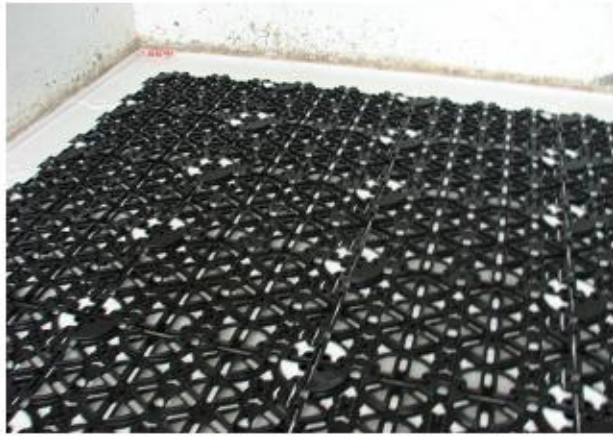
(e) NLS 온돌 지지틀 시공 후
